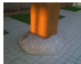
石を基礎に使用した建物。移築が前提なことも和築ならではの。
