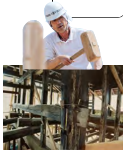
卓越した木組みの技術で施工した屋根裏
